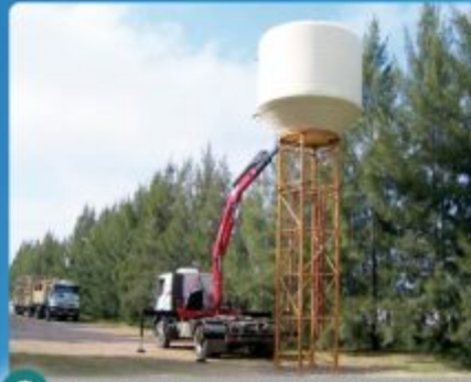
ASESORÍA EN EL MONTAJE Y SERVICIO DE GRÚA PROPIO
